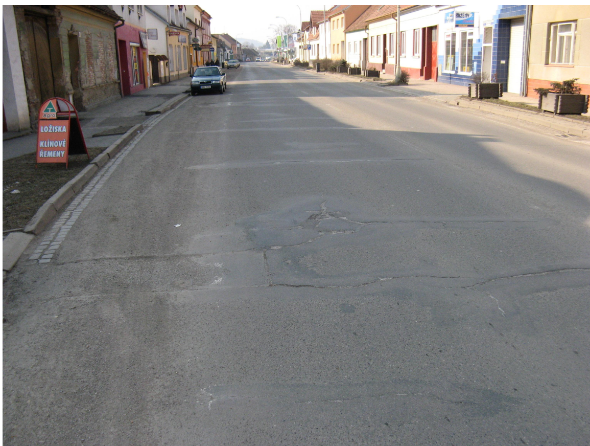
F37, km 45,680 Příčné rozvětvené trhliny s podélnými hrboly.
