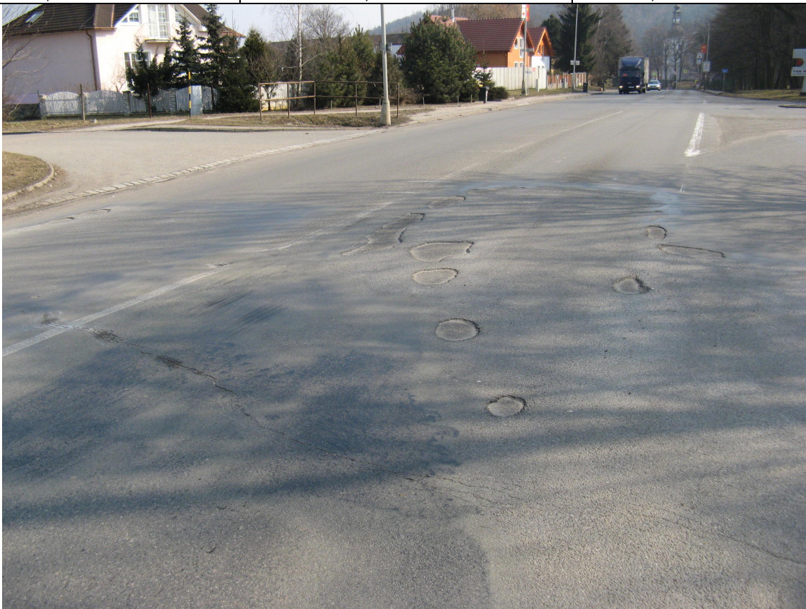
F07, km 44,500 Příčná rozvětvená trhlina, výtluky.
