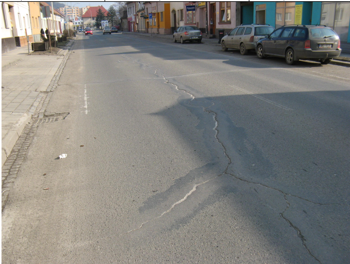
F33, km 45,550 Podélná rozvětvená trhlina.
