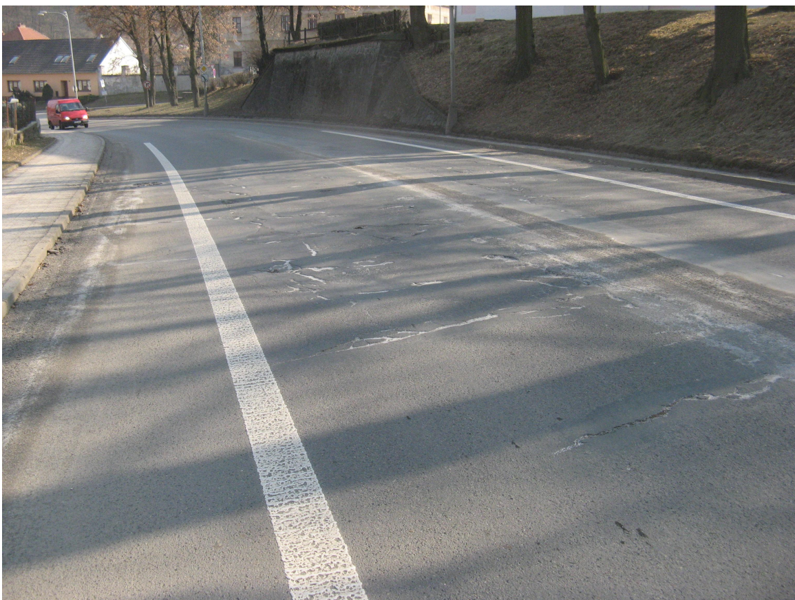
F16, km 44,790 Mozaikové trhliny, rozvětvené nepravidelné trhliny, výtluky.
